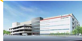
Rakuten Fulfillment Center Chuorinkan 2020年稼働 4万2,000m 2
